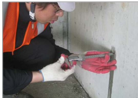
b. 탄산화 깊이 측정
